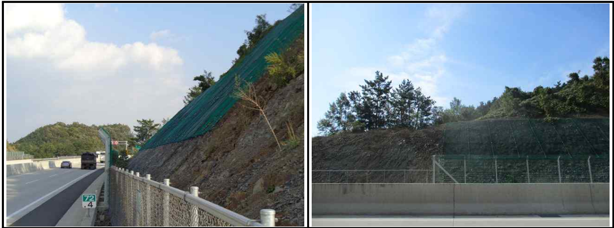
【그림 51.3.4】 보호/보강시설 전경
