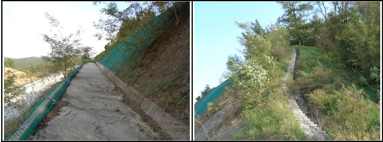
【그림 51.3.3】 배수시설 전경
